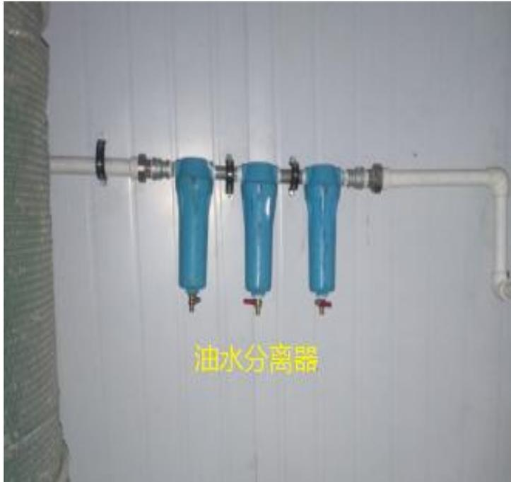
油水分离器每半年可清理一次，只需要将三个阀门打开，排出过滤后的水和油；
